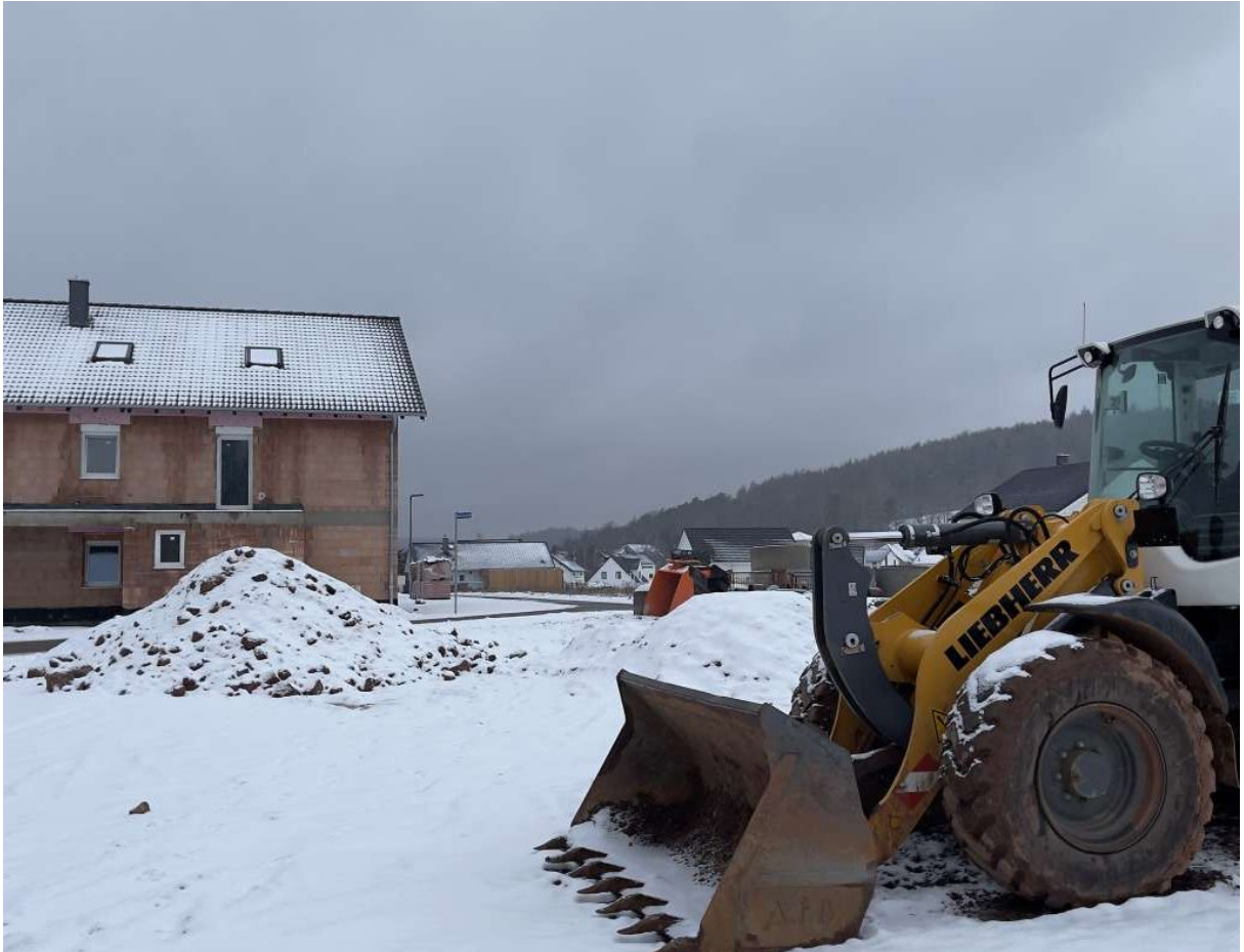
Neubaugebiet Schieferstein in Bad Hersfeld
